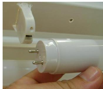
**3 – Antes de colocar a nova lâmpada, atente-se a polarização do pino com a polarização do soquete, indicado no produto pelo adesivo conforme imagem.**
